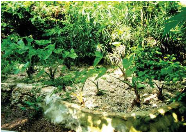
Die Pflanzenkläranlage. Das Grauwasser wird erst durch ein Kiesbeet mit Yam geführt und mündet dann in einen Teich, danach in einen Banana Circle. Rechts kleine Auffangbecken, für Schmutzreste aus Küche und Bad.
