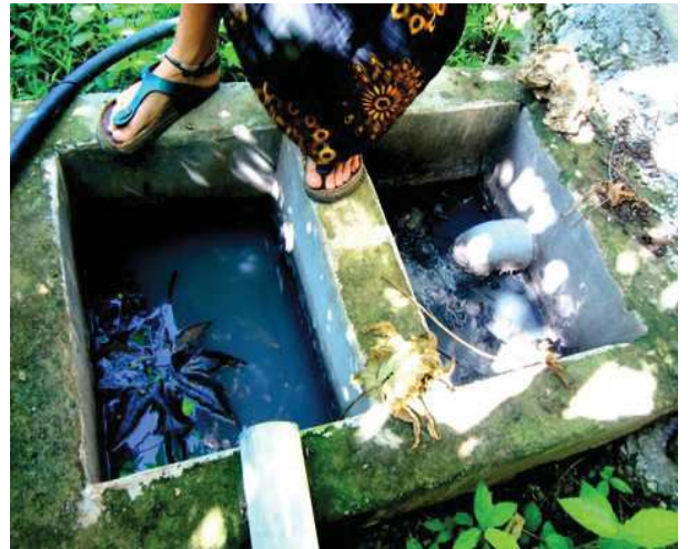
Die Pflanzenkläranlage. Das Grauwasser wird erst durch ein Kiesbeet mit Yam geführt und mündet dann in einen Teich, danach in einen Banana Circle. Rechts kleine Auffangbecken, für Schmutzreste aus Küche und Bad.
